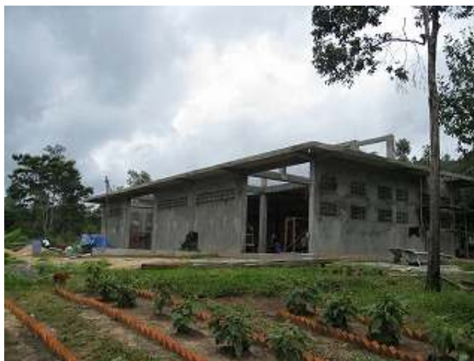
<写真5：グラフィス診療所建設風景>
