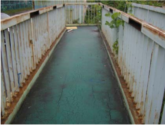
<修復前の歩道橋>
